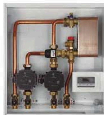
Armario de chapa pintada: 500 x 450 x 160 mm
